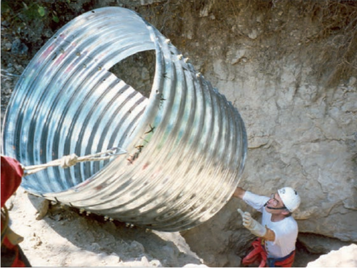
Les obres de col·locació del tub.
